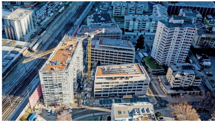
Das derzeit grösste Wohnbauprojekt in der Litterna mit vier Bauten und 138 Wohnungen; Haus A (links im Bild) ist noch nicht fertig erstellt.
